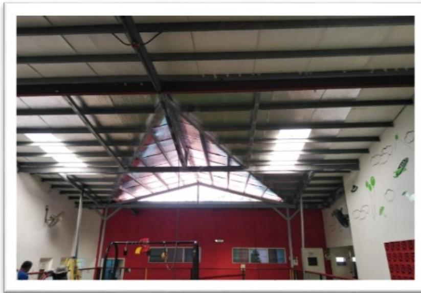
Vista interna del techo del Hogar de la Niñez, donde se aprecia que se dio mayor altura al techo a fin de mejorar la entrada y luz natural y la circulación de aire. La propuesta incluye el reemplazo posterior del material aislante térmico existente.
