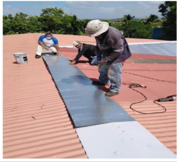
Se reemplazó anterior con un caballete galvanizado para cubrir la unión de las láminas de zinc con inclinación de 2 aguas
