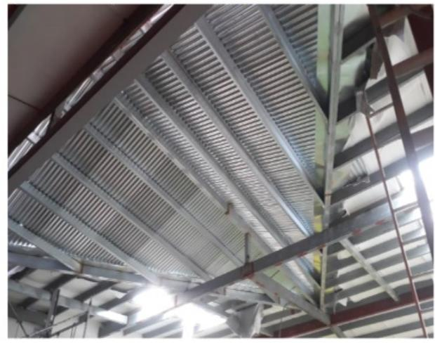
Se realizó la mejora la estructura de los tragaluces dándole mayor amplitud de luz natural, así como se revisaron y mejoraron los soportes de vigas y carriolas existentes. Se ha considerado el reemplazo de las láminas de acrílico transparente denominadas de tragaluces debido a las condiciones existentes.
